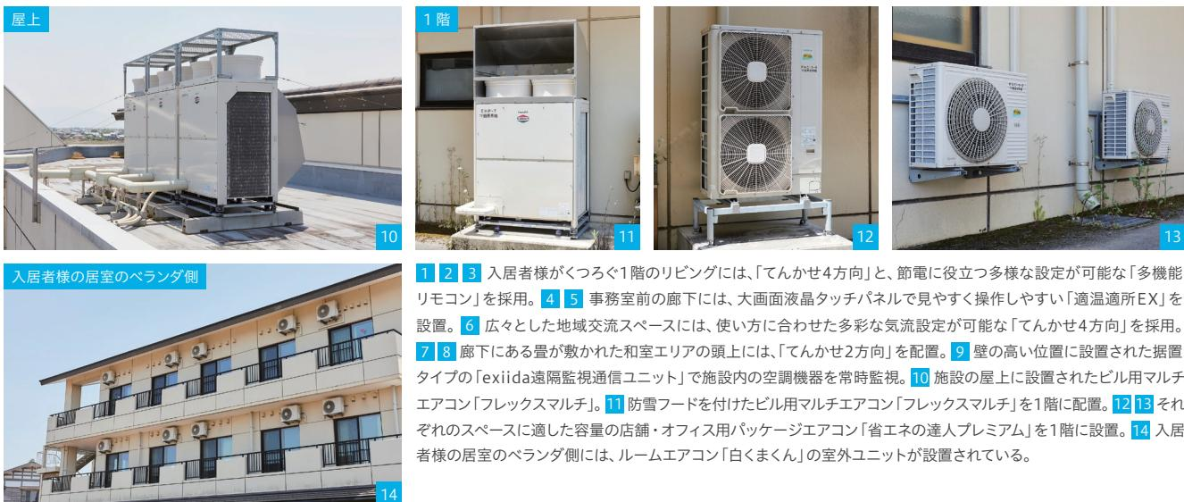
1 2 3 入居者様がくつろぐ1階のリビングには、「てんかせ4方向」と、節電に役立つ多様な設定が可能な「多機能リモコン」を採用。4 5 事務室前の廊下には、大画面液晶タッチパネルで見やすく操作しやすい「適温適所EX」を設置。6 広々とした地域交流スペースには、使い方に合わせた多彩な気流設定が可能な「てんかせ2方向」を採用。7 8 廊下にある畳が敷かれた和室エリアの頭上には、「てんかせ2方向」を配置。9 壁の高い位置に設置された据置タイプの「exiida遠隔監視通信ユニット」で施設内の空調機器を常時監視。10 施設の屋上に設置されたビル用マルチエアコン「フレックスマルチ」。11 防雪フードを付けたビル用マルチエアコン「フレックスマルチ」を1階に配置。12 13 それぞれのスペースに適した容量の店舗・オフィス用パッケージエアコン「省エネの達人プレミアム」を1階に設置。14 入居者様の居室のベランダ側には、ルームエアコン「白くまくん」の室外ユニットが設置されている。
